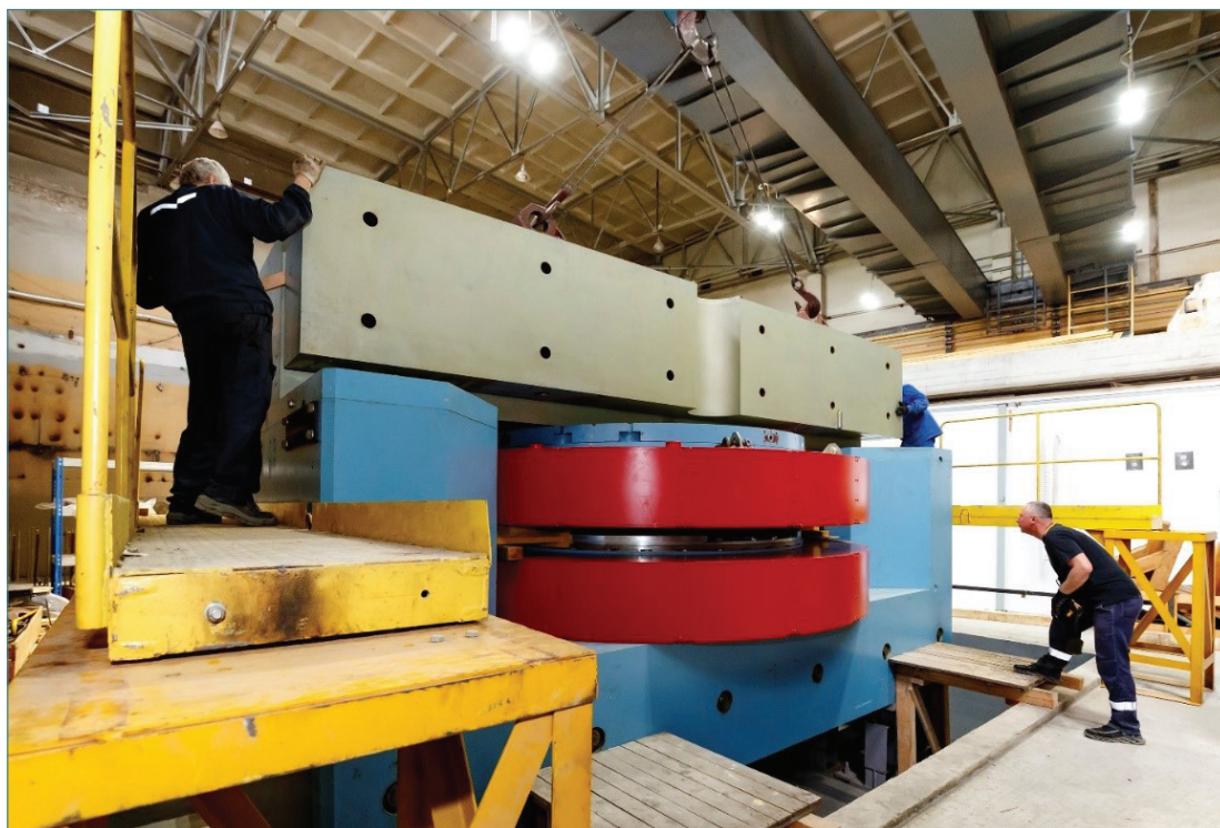
Монтаж циклотрона ДЦ-140
