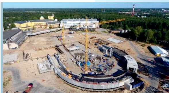
Строительная площадка комплекса NICA
