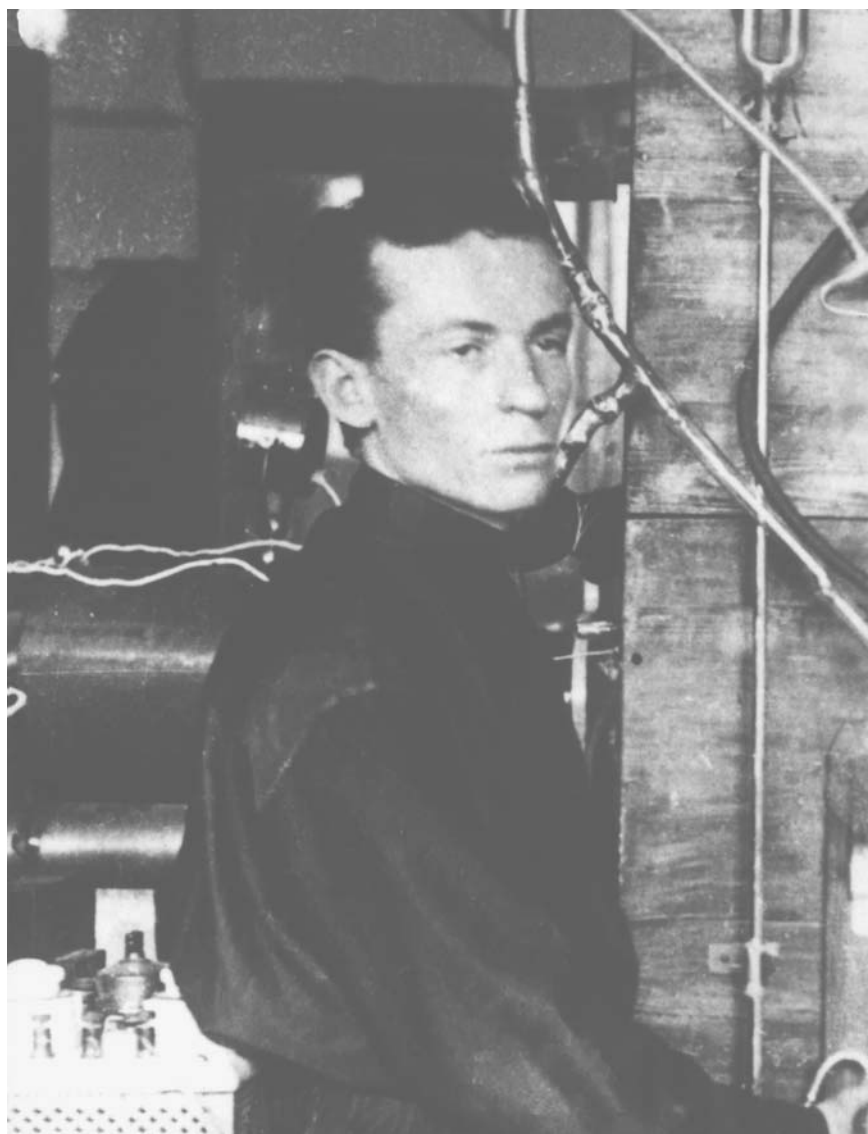
В. И. Векслер — электромонтер на ситценабивной фабрике им. Я. М. Свердлова. 1927 г.
