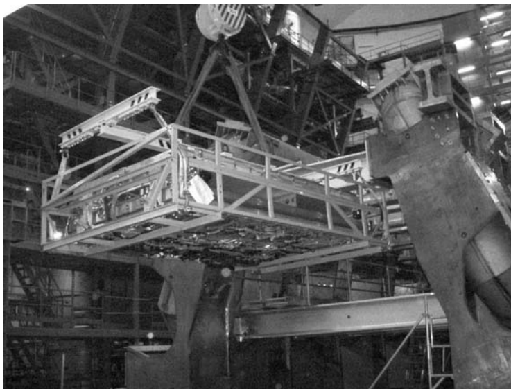
Рис. 6. Момент инсталляции первого модуля в шахту экспериментальной установки ATLAS
