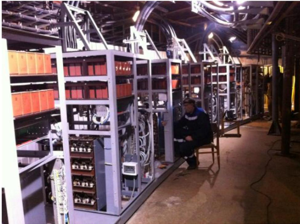
Рис. 1.4. Монтаж ключей эвакуации энергии в специально подготовленном помещении в цокольном этаже здания синхрофазотрона
