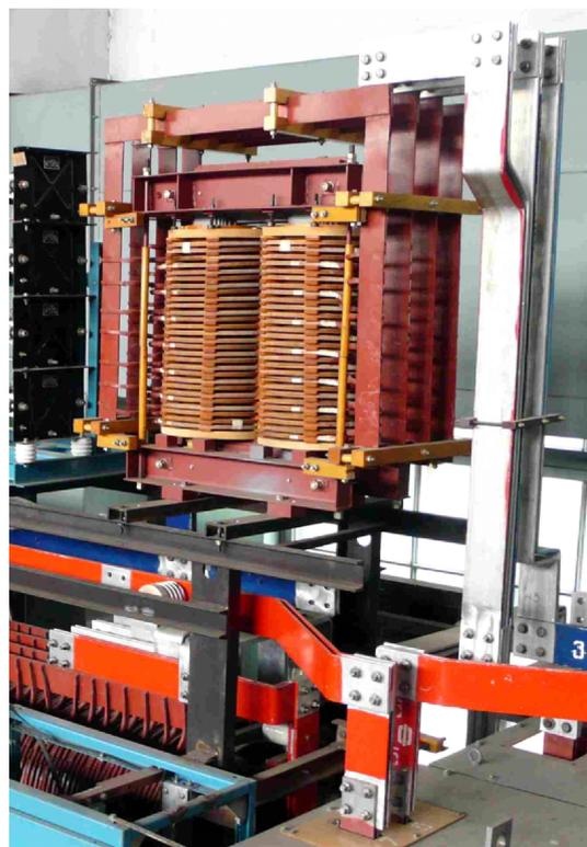
Рис. 1.6. Тиристорный выпрямитель и элементы фильтра источника 20ТВ
